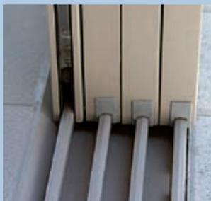
Alle Elemente des 1- bis 4-gleisigen Systems sind frei verschiebbar.
